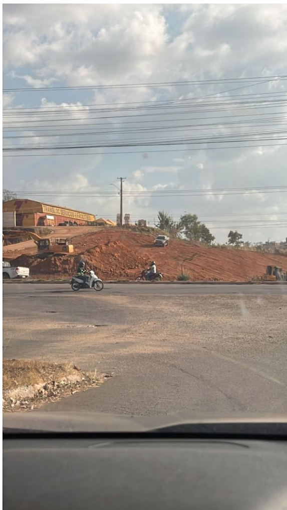
Imagem 9. Maquinário em operação junto à pista: escavadeira, máquina que aparenta ser trator de esteira e veículo sobre o aterro, com motocicletas trafegando ao lado.
