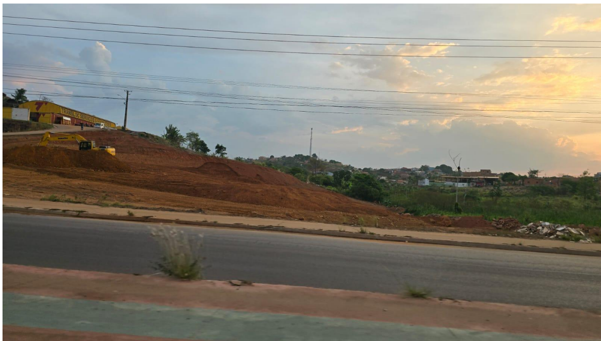
Imagem 5. Talude terraplanado próximo ao galpão usado como referência. À direita, baixada com vegetação e entulho depositado na margem da área.
