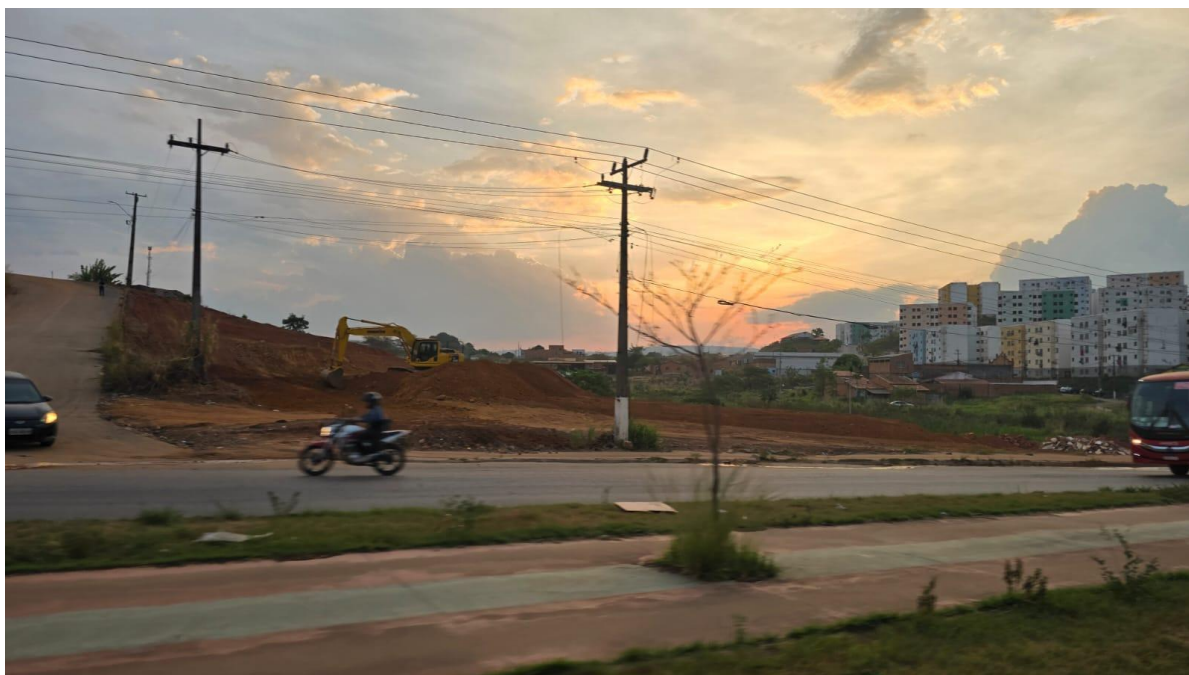
Imagem 2. Mesma frente de serviço, com os conjuntos residenciais ao fundo, mostrando a proximidade da intervenção com a rodovia e com as moradias.
