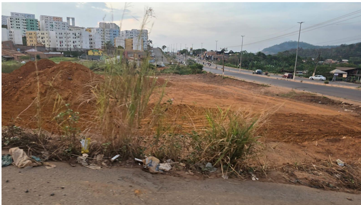
Imagem 3. Solo exposto e montes de terra às margens da rodovia, com resíduos na borda da pista e edifícios residenciais ao fundo.
