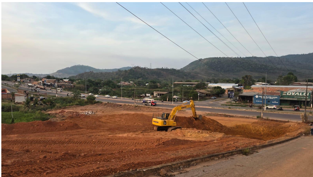
Imagem 4. Vista elevada da área. Escavadeira hidráulica Komatsu escavando e amontoando terra em trecho rebaixado do terreno, com a Rodovia PA-160 ao fundo.
